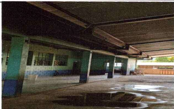
Foto 1: Se observa el deterioro de los canales, con el agua espozada en el piso cada vez que llueve. Módulo 7.
